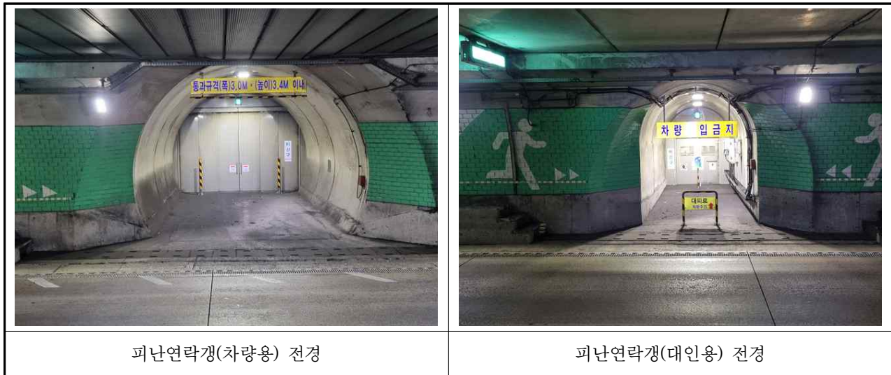
【사진 3.3.37】 피난연락갱 전경
